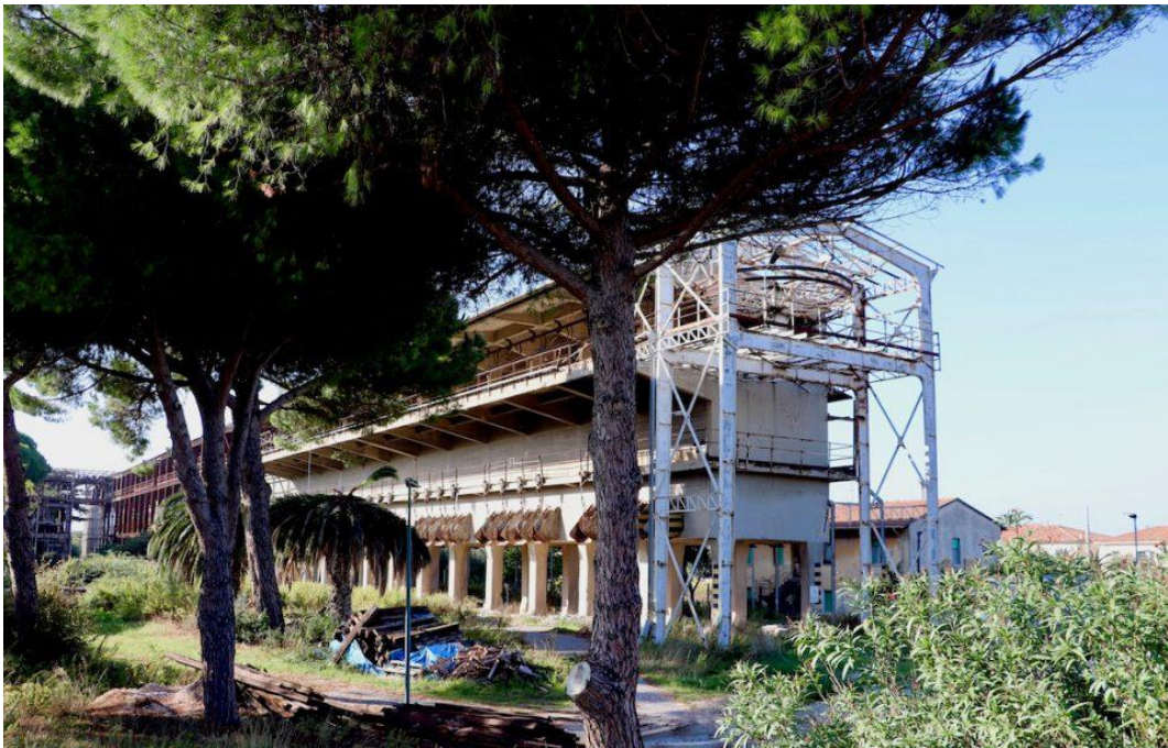
Fig. 16 - Struttura di Nervi, San Vincenzo
